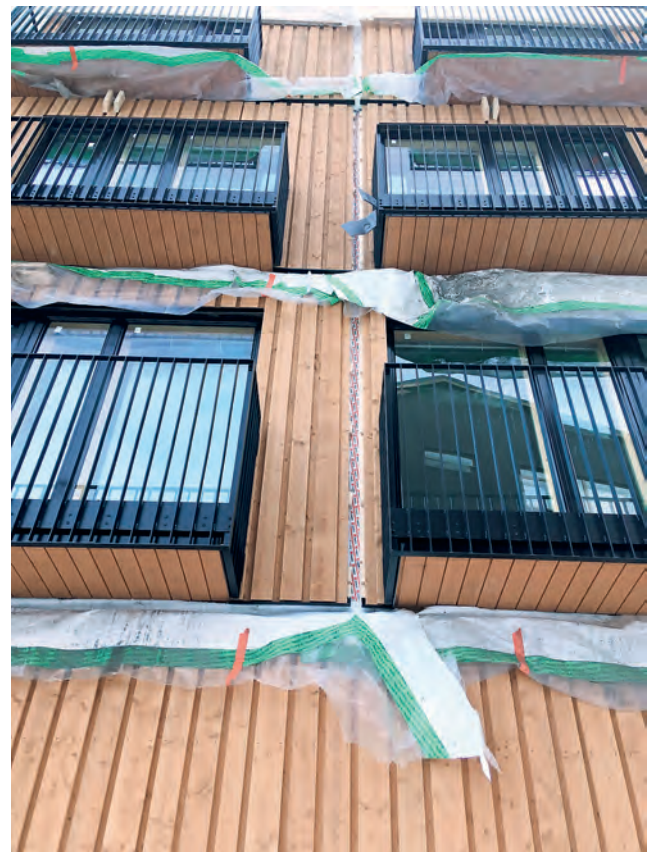
Kuva 1. Lumipuun julkisivun elementtien väliset vaaka- ja pystysaumot viimeisteltiin työmaalla.
