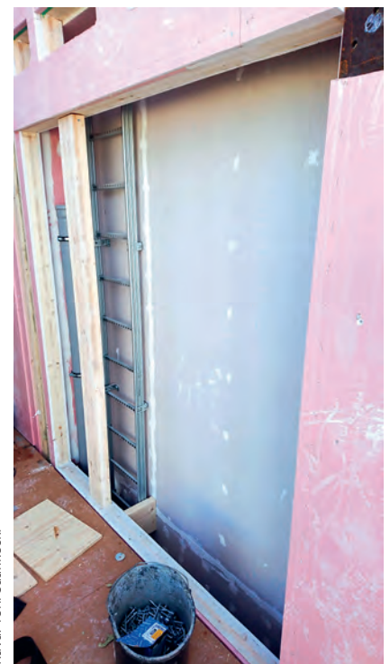
Kuva 10. Tyhjä tekniikkakuilun varaus työmaalla.
