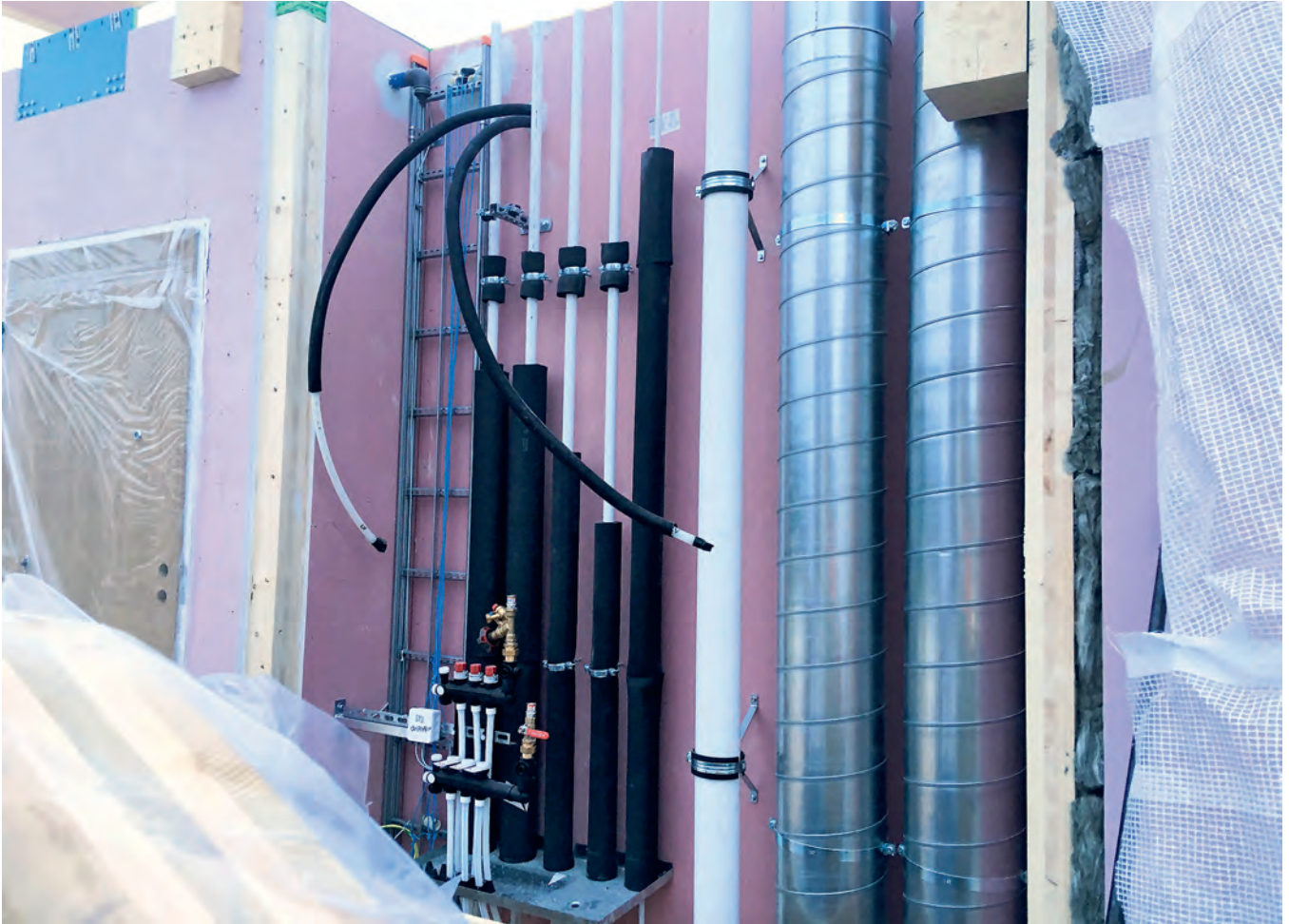
Kuva 9. Talotekniikkahormi Lumipuussa.
