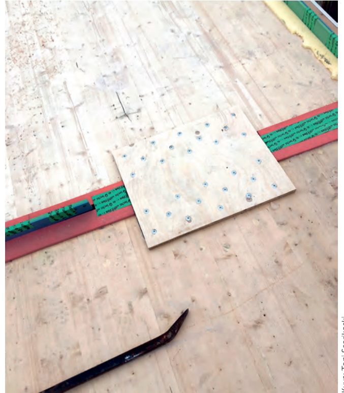
Kuva 6. Kahden elementin välinen vaneriliitos elementtien katolla.
