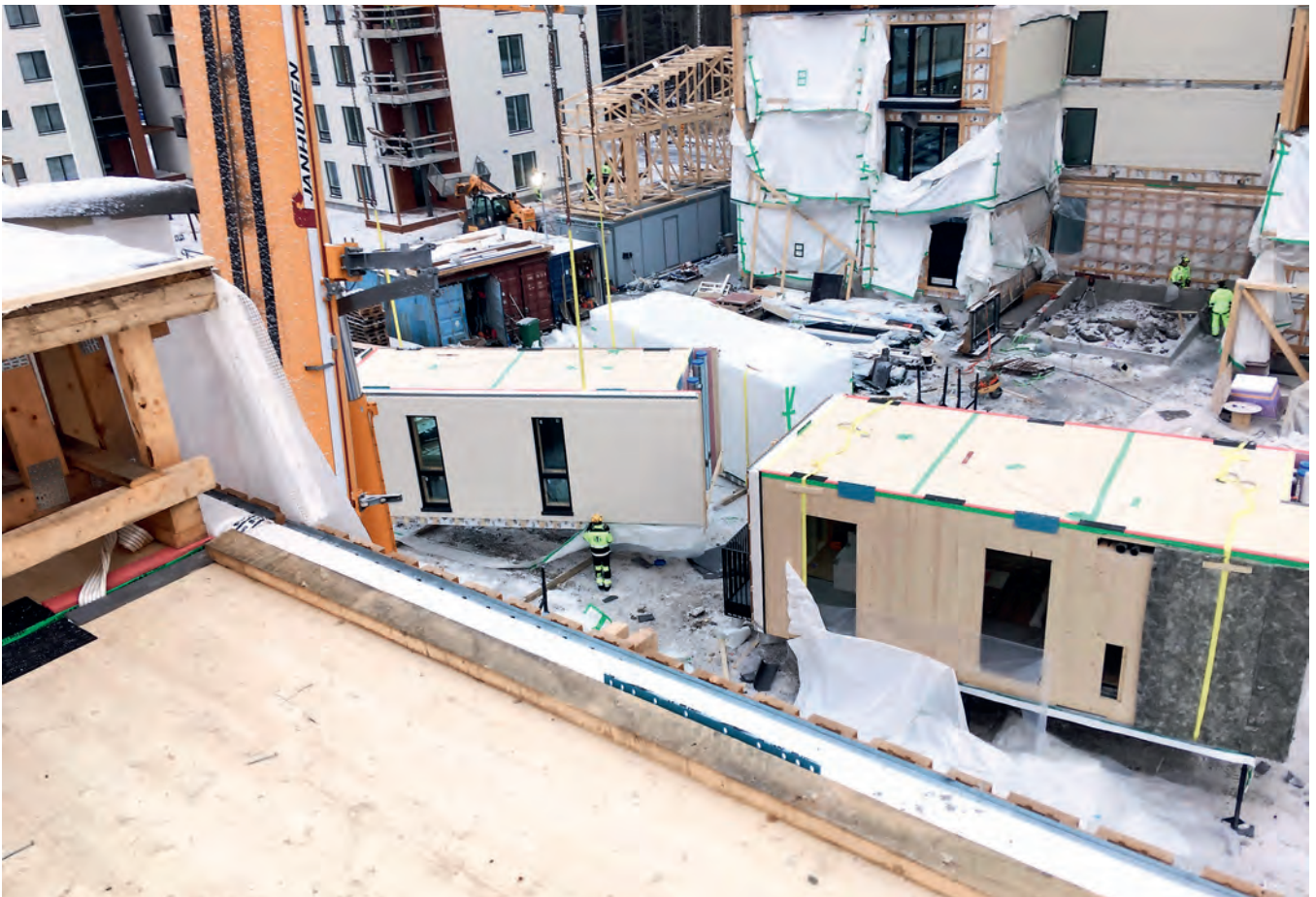
Kuva 3. Elementin nostaminen liinanostona.
