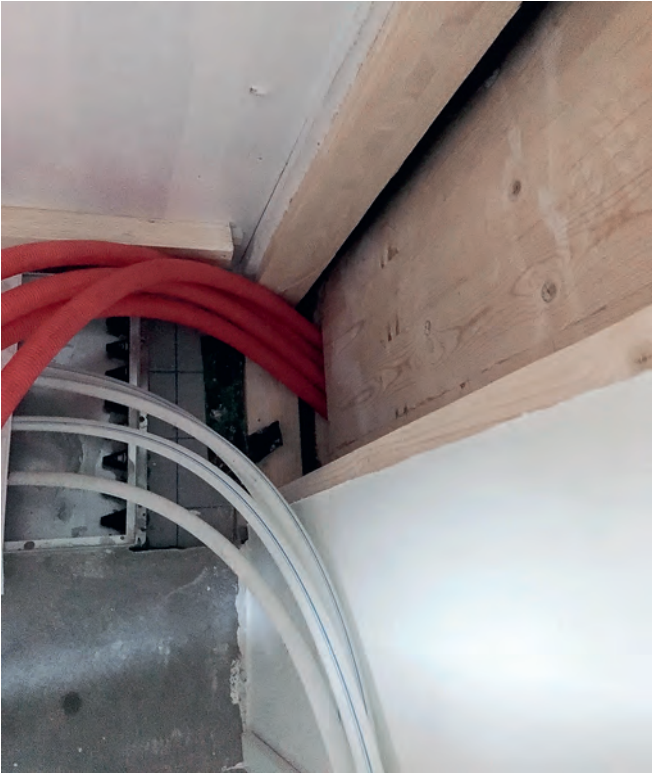
Kuva 5. Putkien ujutus viereiseen elementtiin.
