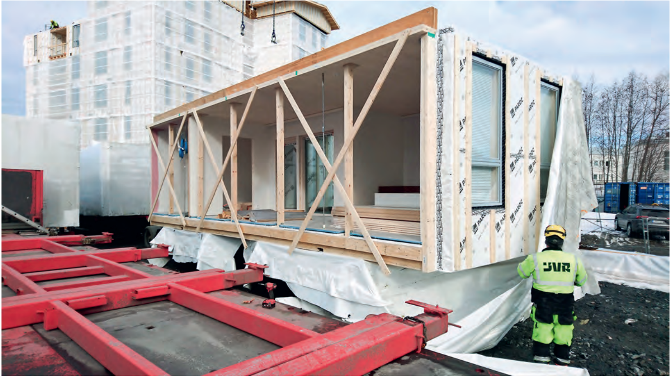
Kuva 4. Yhdeltä puoleltaan avoimen elementin väliaikainen tuenta.
