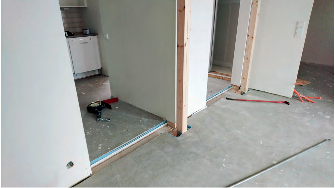
Kuva 8. Kahden elementin välinen liitos asennuksen jälkeen.
