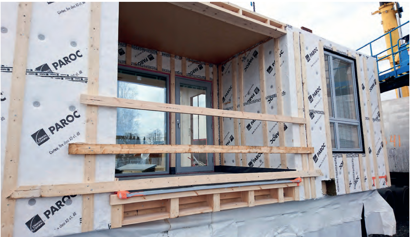
Kuva 14. Työnaikainen putoamissuojaus kiinnitettynä parvekkeelle.
