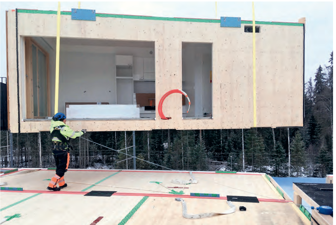
Kuva 7. Kahdesta moduulista koostuvan asunnon kytkettävät tekniikat.
