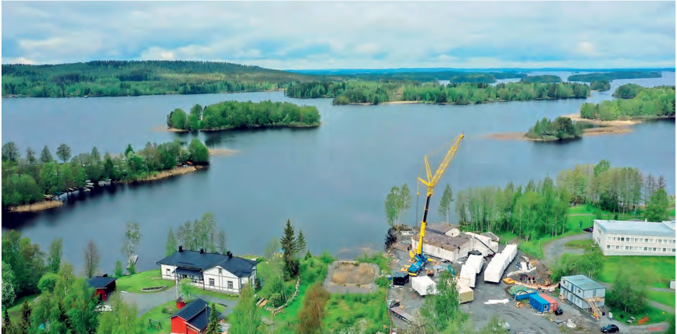
Kuva 2. Ajoreittien ja varastopaikkojen suunnittelu tontille on tärkeää. Kuopion Kallaveden rannan työmaalle varastoituja elementtejä.
